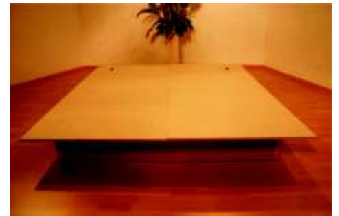
Auflegen der Bodenplatten
